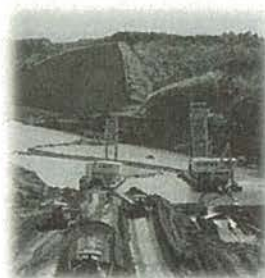
捷水路 (建設中)
