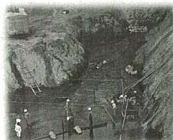
大和田機場 (建設中)
