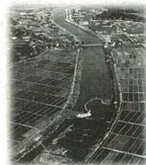
疎水路上流部
