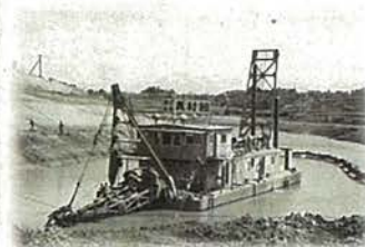
建設中の様子
