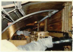
昭和54年度 4号トンネル鋼管内巻工の施工状況
