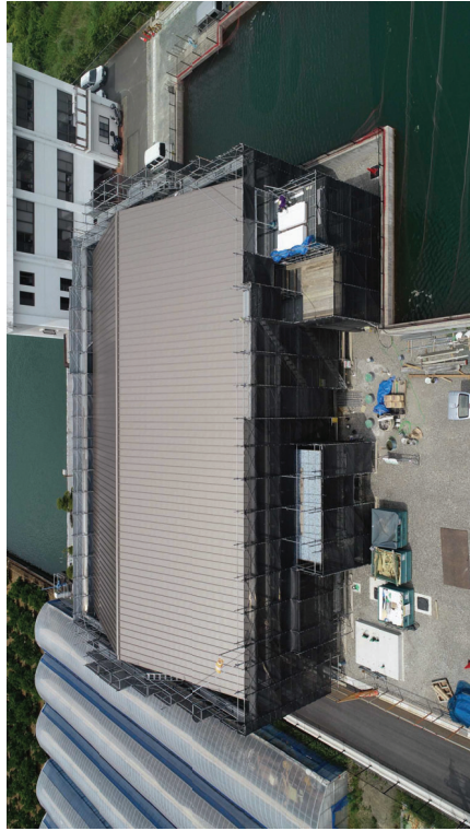
施工状況（R4年6月撮影）
