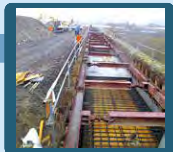
内型枠設置工
