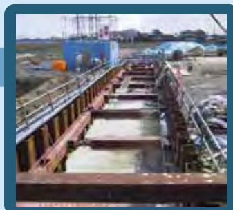
コンクリート打設工
