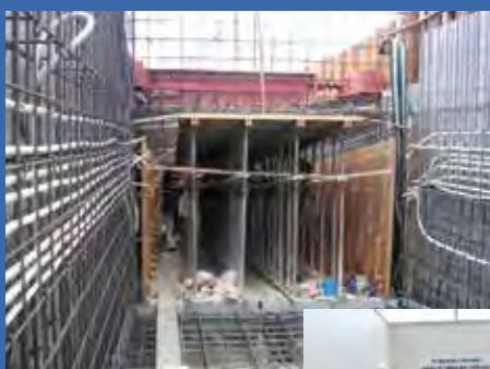
地下歩道工事
