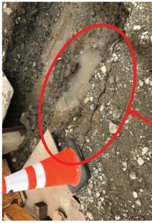
② CB注入前の引抜状況
