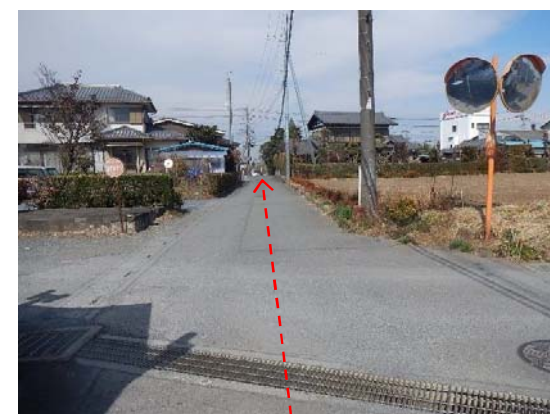
写真-1.1.1.7 下流側推進工区間 管渠起点部上流側から望む
