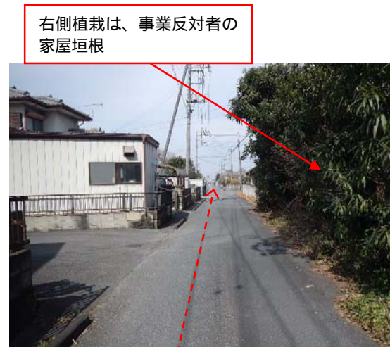
写真-1.1.1.16 下流側推進区間 左側は宅地進入路
