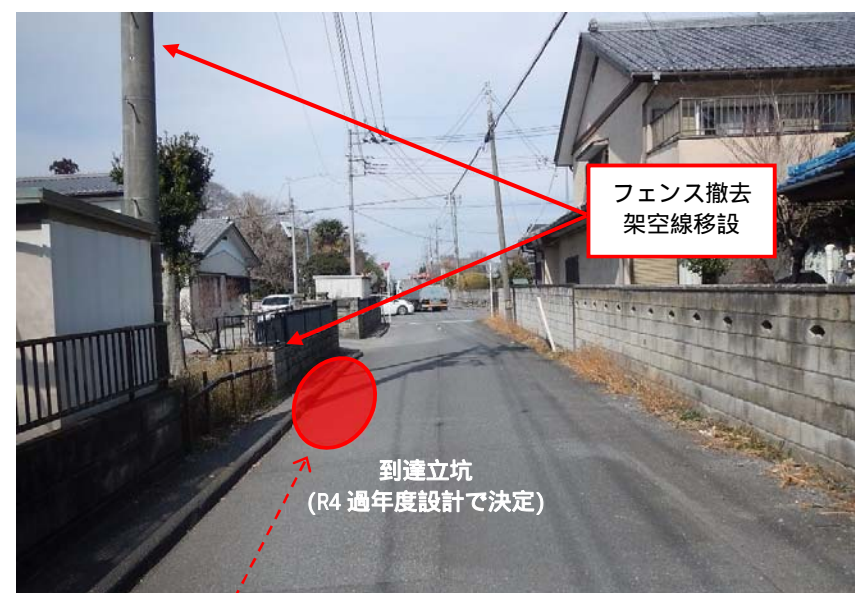
写真-1.1.3.2 到達立坑
