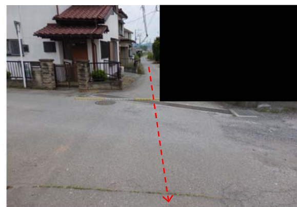
写真-1.1.1.6 上流側推進工区間
