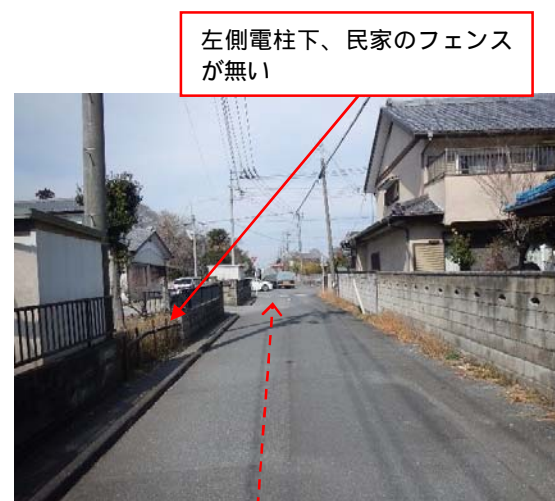
写真-1.1.1.17 下流側推進区間 民家密集地
