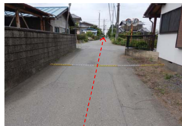
写真-1.1.1.5 上流側推進工区間
