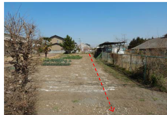
写真-1.1.1.1 上流側推進工区間 開削工との区境
