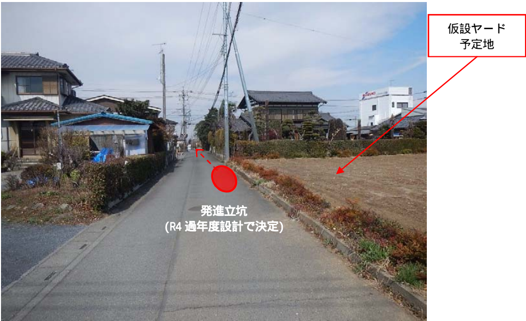
写真-1.1.1.20 発進立坑
