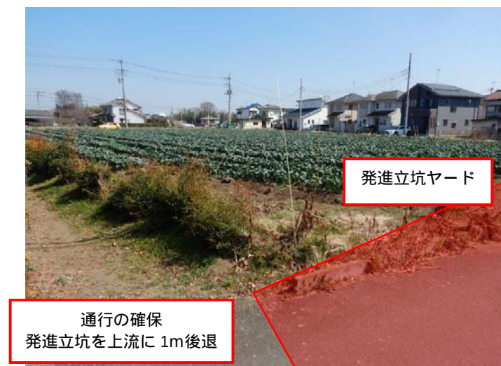
写真-1.1.3.1 発進立坑全部私道全景
