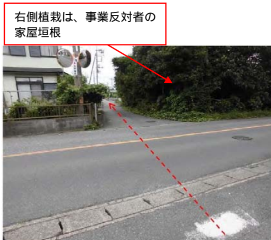
写真-1.1.1.13 下流側推進区間 県道62号を望む
