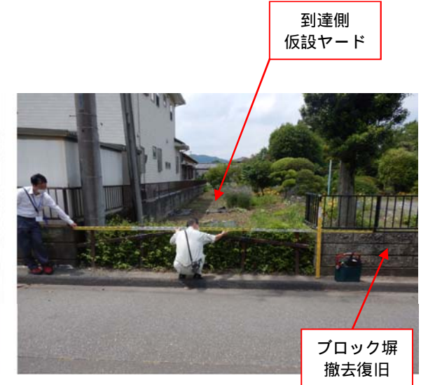
写真-1.3.2.4 到達側仮設ヤード
