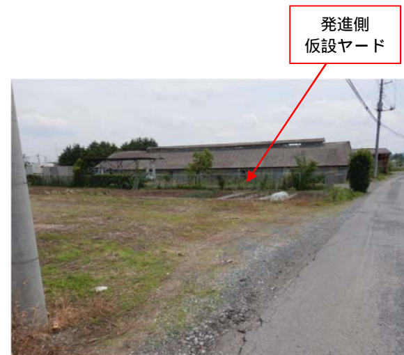
写真-1.3.2.2 発進側仮設ヤード
