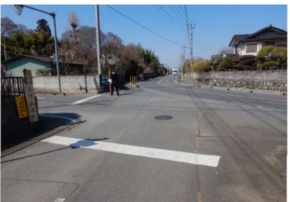
写真-1.3.2.8 到達発進側工事用進入路
