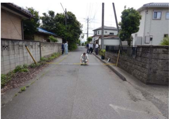
写真-1.3.2.7 到達側工事用進入路
