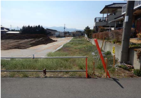
写真-1.3.2.5 発進側工事用進入路
