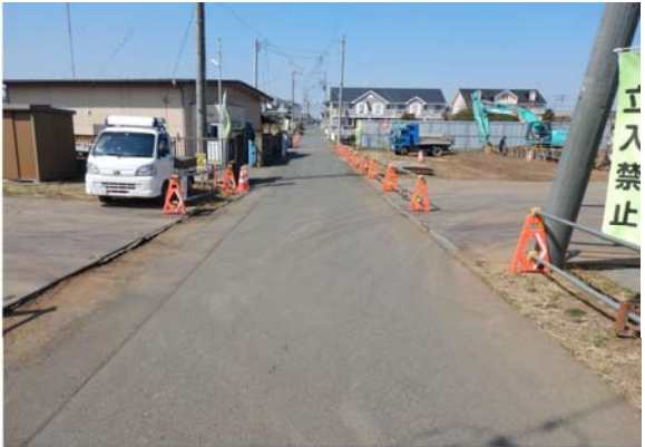
写真-1.3.2.6 発進側工事用進入路
