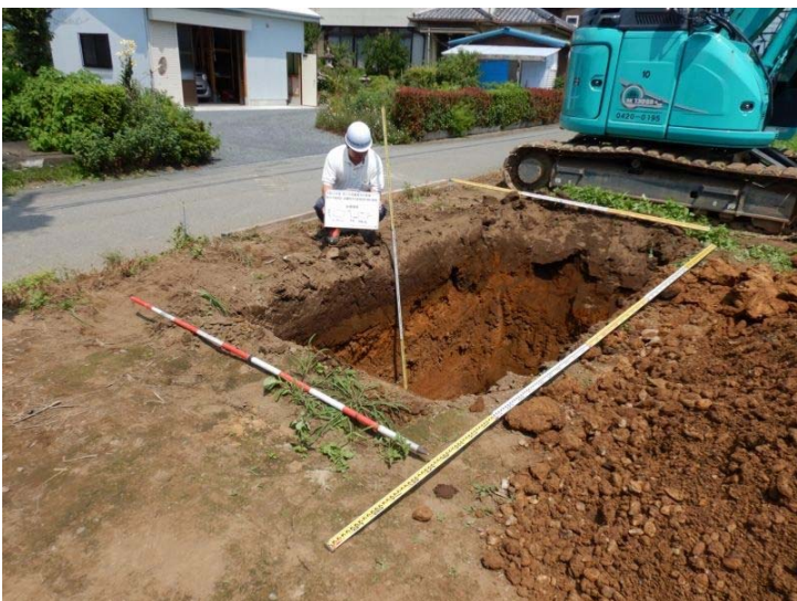
試掘孔全景 南東側より ローム層の深度は GL-2.55m まで。以深、砂礫層 (Dg2) を 4.0m まで掘削した。
