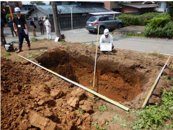
試掘孔全景 北東側より
