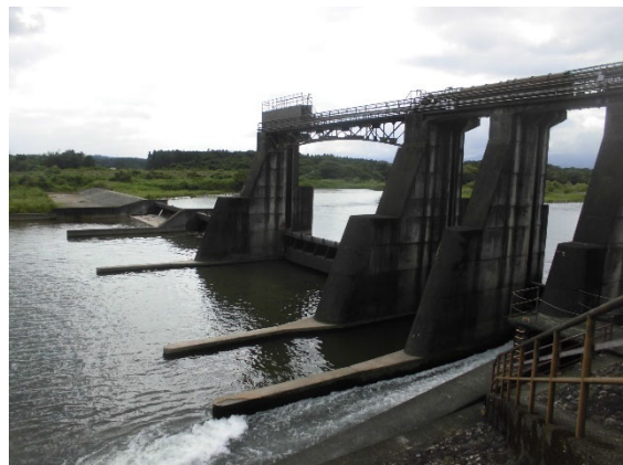
【現地調査状況】
