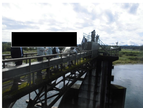
【現地調査状況】
