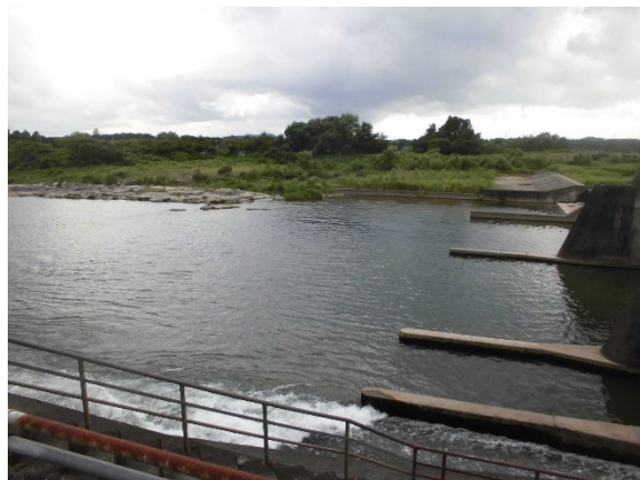
【現地調査状況】
