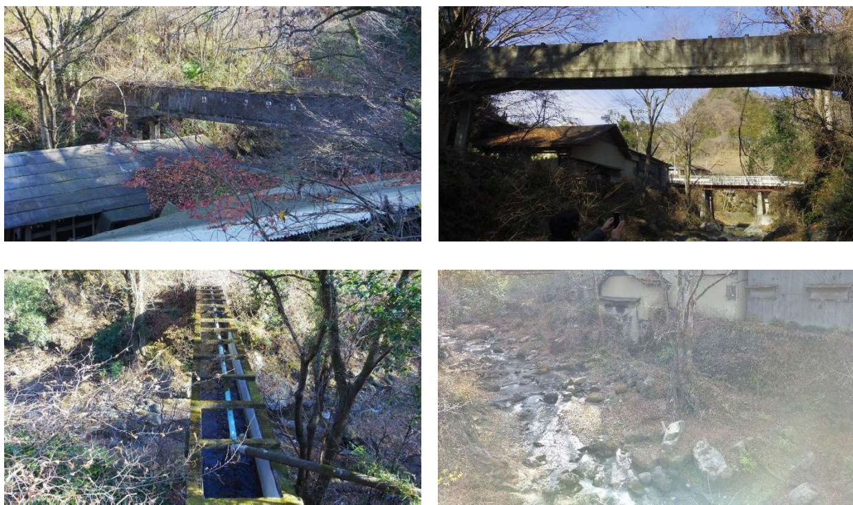
図 3.1-3 南牧導水路 1 号水路橋 写真（2025 年 12 月撮影）
