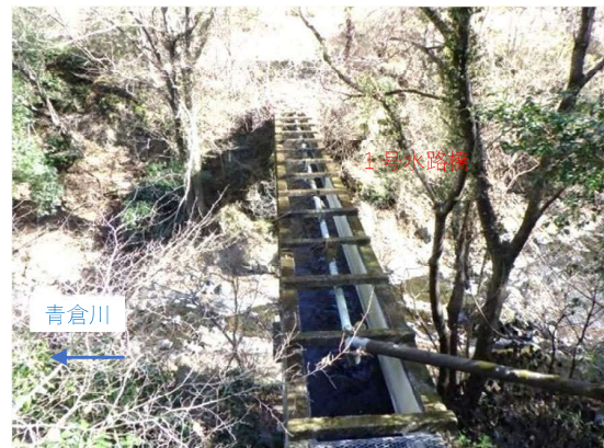
写真-2.2 水路橋上流側の全景
