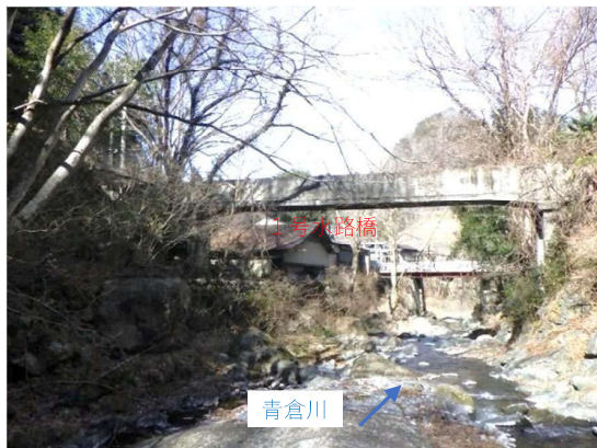
写真-2.1 河川内から水路橋全景
