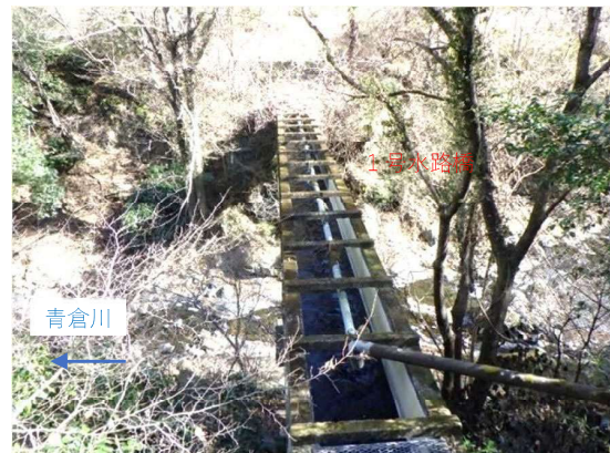
写真-2.2 水路橋上流側の全景
