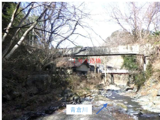
写真-2.1 河川内から水路橋全景
