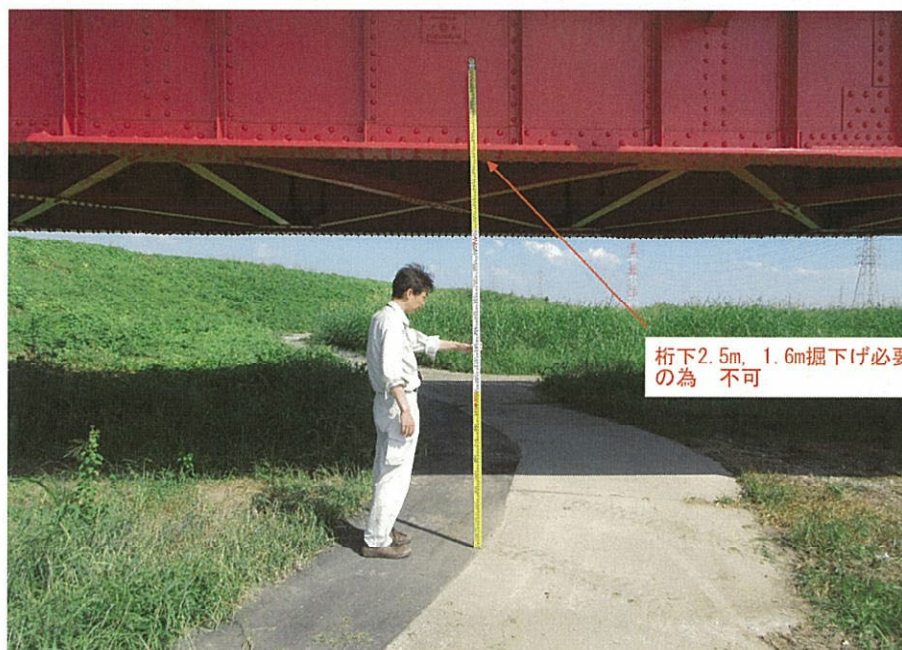
図 滝岡橋左岸桁下状況
