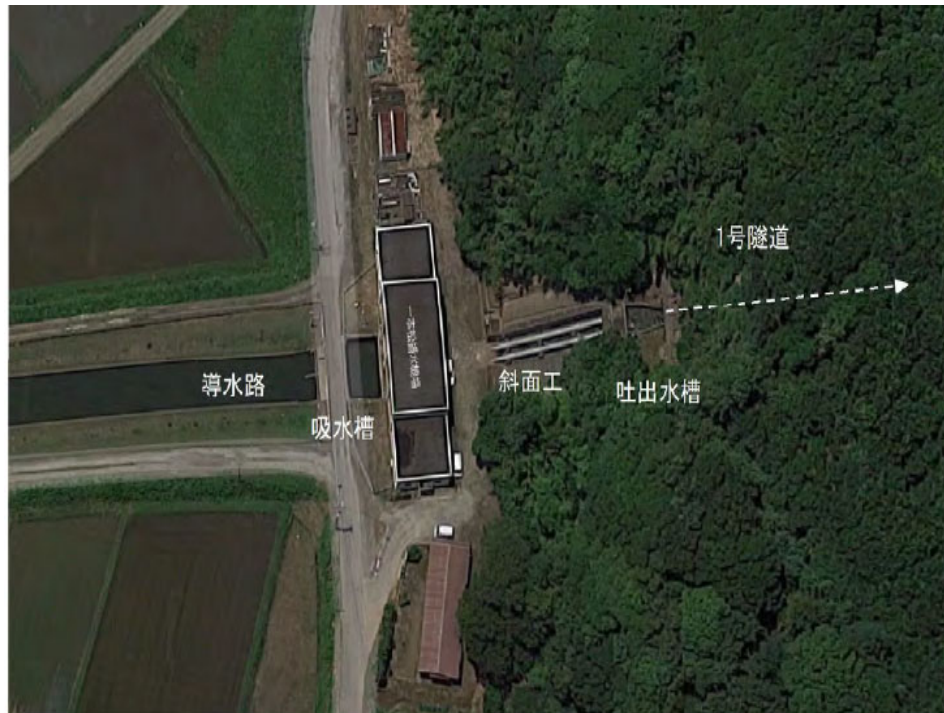
図 3.1-3 一本松機場 上空写真
