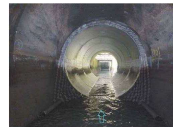
鋼管内挿写真
