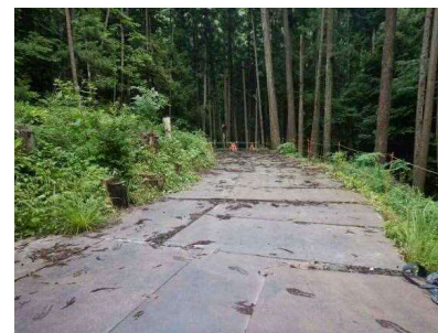
水路側よりヤード入口方向
