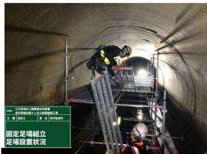
足場設置状況
