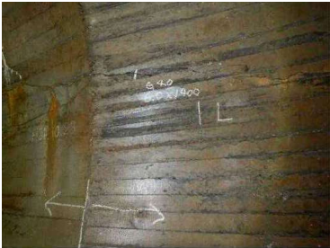
トンネル縦断ひび割れ状況
