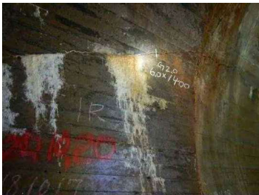
トンネル縦断ひび割れ状況
