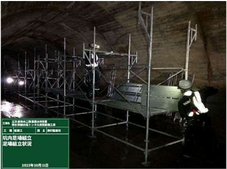
足場組立状況
