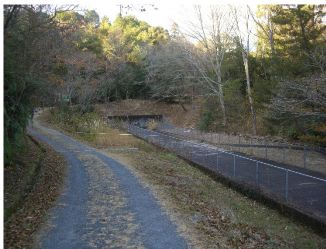
(写真2：5号バイパストンネル下流側坑口)
