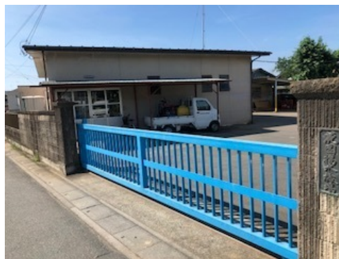
花園揚水機場（現況）
