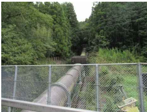
(写真 3 : 2・3 号トンネル下流坑口)
