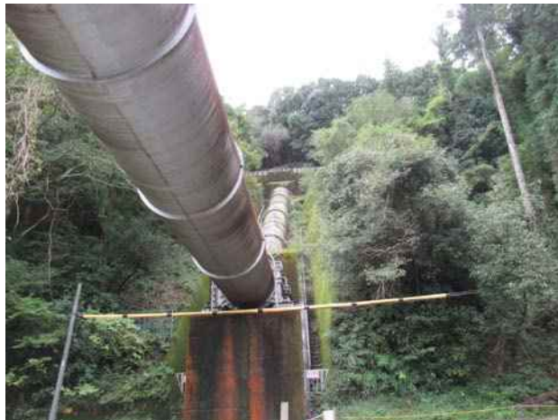
(写真 1 : 4 号トンネル上流坑口)
