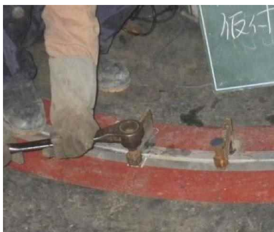
鋼管の仮付け・芯出し状況
