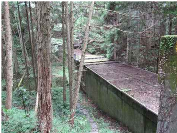
(写真 2 : 1 号トンネル下流坑口)
