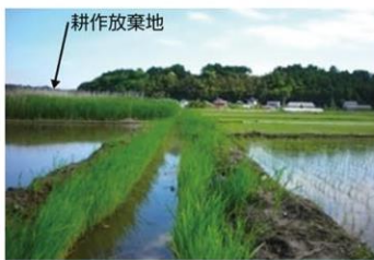
土水路による排水不良
