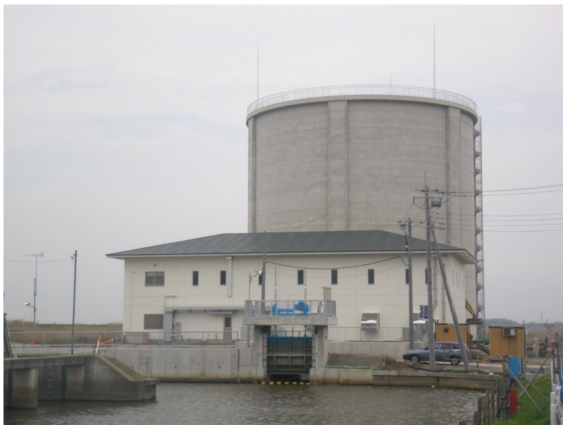
完成した白山甚兵衛機場
