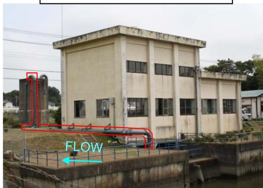
高揚程ポンプを改造し、低揚程分の水量を補っているが、水量が不足しているため、H22年度に新たに仮設の水中ポンプを設置して補給
