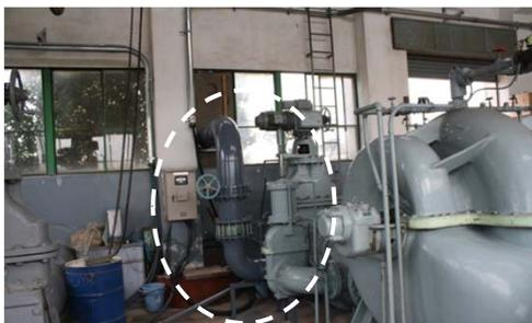
高揚程のポンプを改造し、低揚程分の水量を補給
