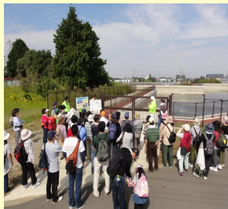
上里幹線呑口調整池
