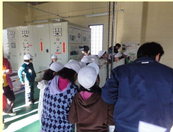
神流川発電所見学
