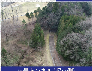
5号トンネル(起点側)
