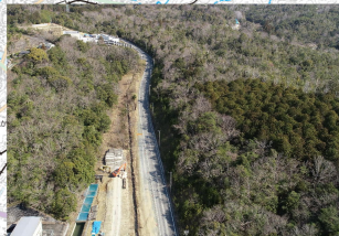
6号トンネル(終点側)
