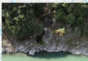
長石放水路(下流部:天竜川)
