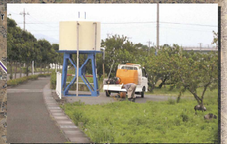
散水補助タンク
