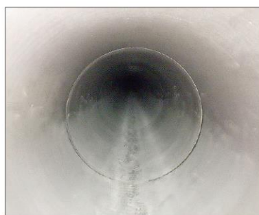
天竜川伏越 内挿管設置(整備後)
