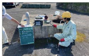
阪本幹線阪本調整水槽流量計 (管対地電位測定状況)
