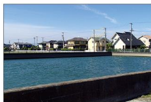
用水安定供給のための調整池
