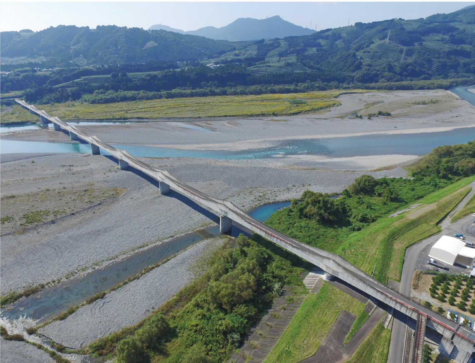
大井川水路橋(大井川用水地区)
