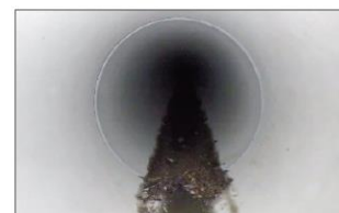
佐粟谷サイホン管更生(ARISライナー)状況
