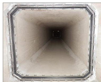
前河原伏越 伸縮目地設置(整備後)
