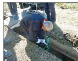
農家による用水路修繕
