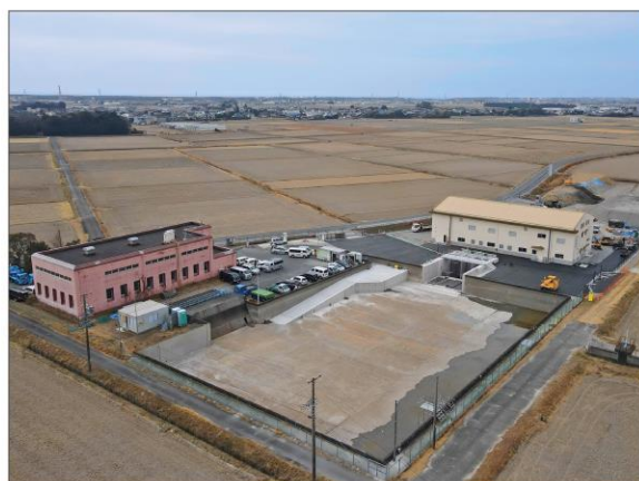
浅羽揚水機場 全景
