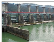
取水施設(船明ダム)
