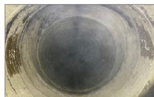
丹野川サイホン管更生(ダンビー)状況
