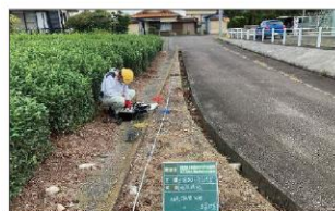
標原幹線標原調整水槽流量計 (土壌測定抵抗測定状況)
