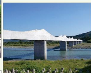
大井川水路橋
