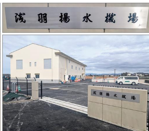
田園景観と調和した建屋外観
