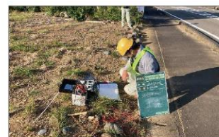
中-3号支線25-3号分水工 (土壌測定抵抗測定状況)
