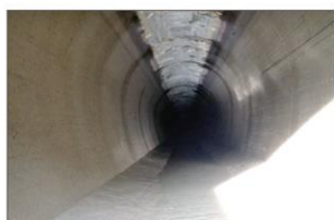
大井川幹線水路(水路トンネル)
