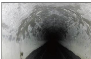
導水路(水路トンネル)
