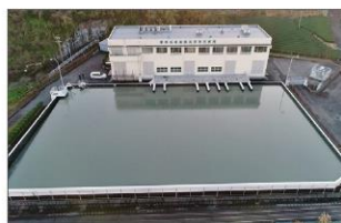
牧之原揚水機場
