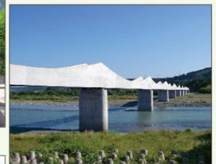
大井川水路橋
