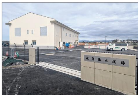
田園景観と調和した新機場の建屋外観
