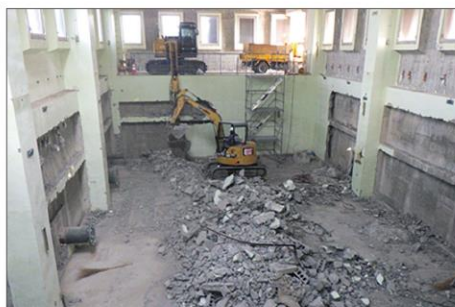
旧機場の撤去状況(内観)
