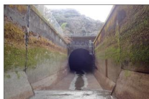
大井川左岸幹線水路(水路トンネル)
