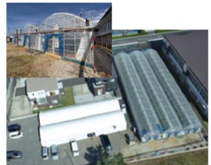
ハウスと作業場の外観
