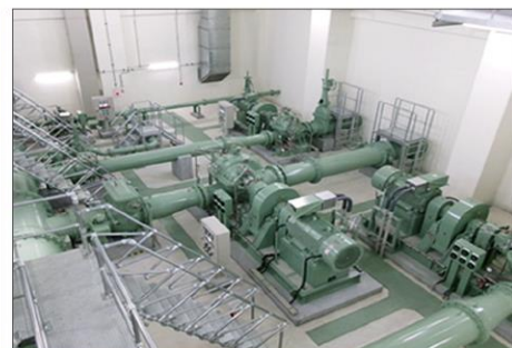
据付が完了した新機場のポンプ設備
