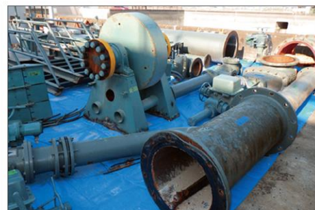
旧機場の撤去されたポンプ設備
