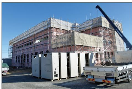
旧機場の撤去状況(外観)
