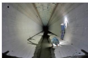
機能診断調査の様子
