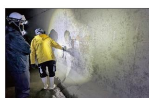
機能診断調査の様子
