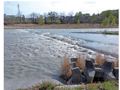
天竜川高水位時の伏越状況（左岸上流より）
