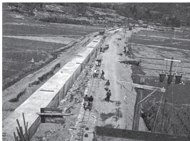
前河原伏越施工状況写真（昭和30年度竣工）
