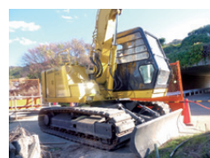
使用する重機
