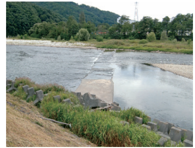
天竜川低水位時の伏越状況（左岸上流より）
