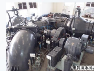
手賀排水機場
