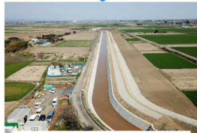
新荒川排水路の改修（平成30年度）
