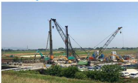
工事施工（杭打ち）状況 （令和2年6月）
