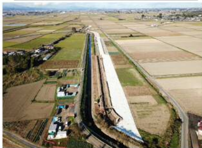
排水路の改修（平成30年度～施工）
