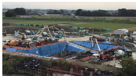
底版コンクリート打設風景
