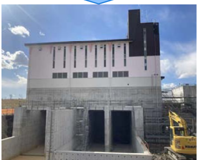
令和4年1月（機場本體工（建築建屋）、呑口部施工）
