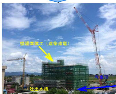
令和3年7月 （機場本體工（建築建屋）、吐出水槽、吸込水槽施工）
