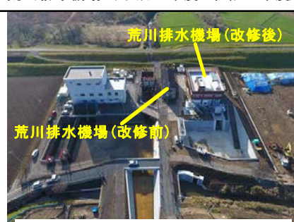
令和3年5月（荒川排水機場完成）
