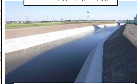
令和3年3月（新荒川排水路完成）
