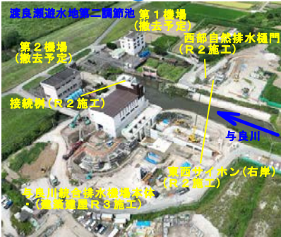
令和4年9月 （吸込水槽本体・呑口部、吐出水槽本体・暗渠、 接続樋、建築建屋本体、樋門接続水路 完成）
