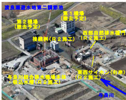
令和3年3月 （吸込水槽、西部自然排水樋門、東西サイホン（右岸）施工）
