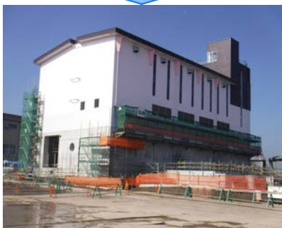
令和3年11月 （機場本體工（建築建屋）、吐出水槽、吸込水槽施工）
