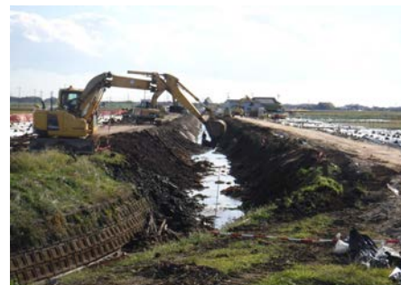
令和3年11月 （西清水川排水路その3工事 積ブロック取壊し工）
