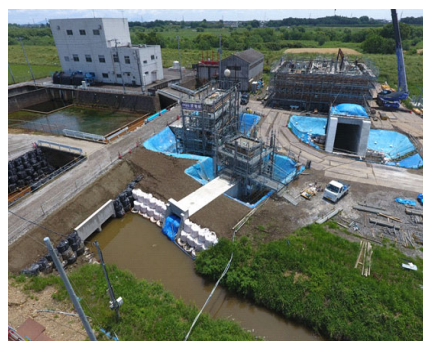
令和2年6月（建屋躯体型枠締固め、制水門躯体のコンクリート打設）
