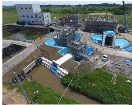
令和2年6月（建屋駆体型枠締め、制水門駆体のコンクリート打設）
