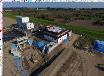
令和2年11月（遊水池造成、樋管上流部駆体のコンクリート打設）
