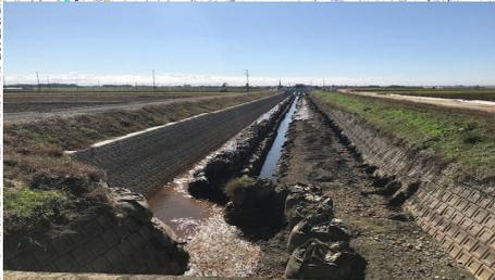
新荒川排水路改修その14工事の仮設工（上流側から撮影。左岸側は昨年施工済、右岸側は今年度施工）
