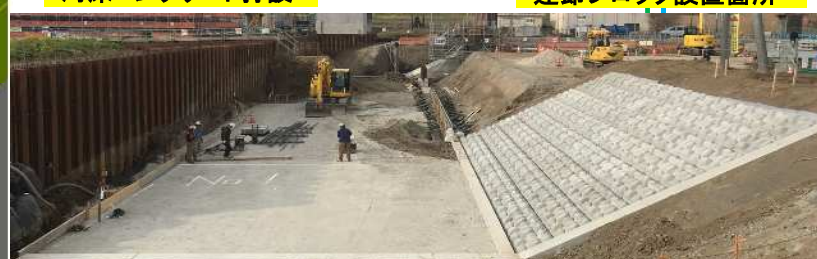
河床コンクリート打設
