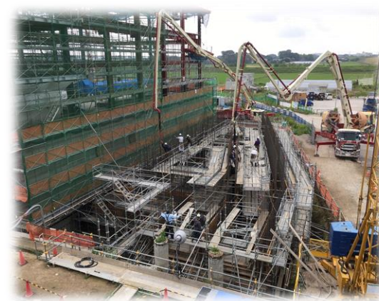
6月3日 吐出水槽コンクリート打設状況
