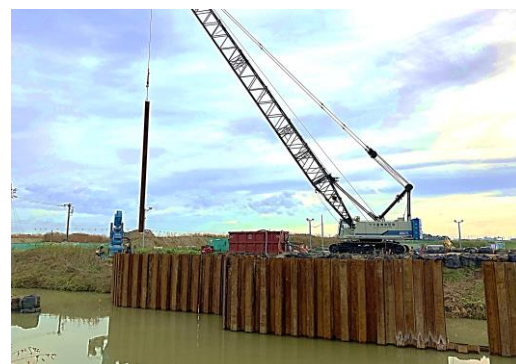
鋼矢板打設の様子
