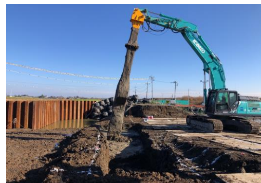
地盤改良の様子
