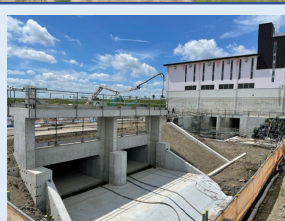
東部排水樋門埋め戻しの様子
