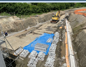
西部幹線護岸ブロック積みの様子
