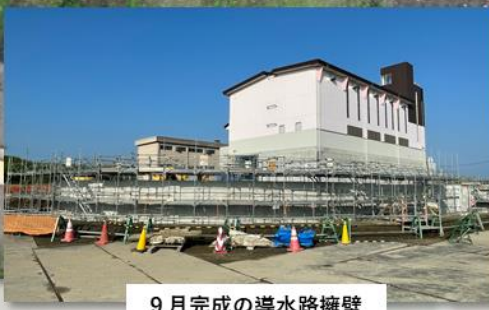
9月完成の導水路擁壁
