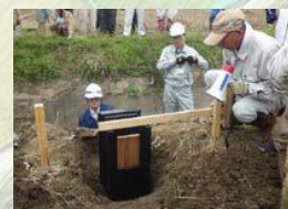
落水柵設置の様子
