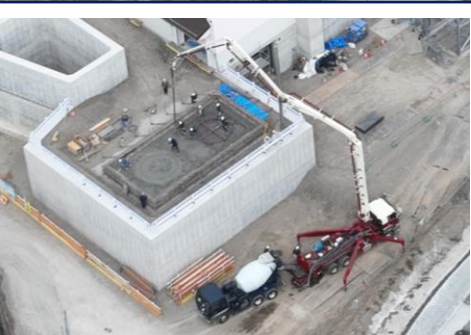
1 貯油タンク基礎コンクリート打設
