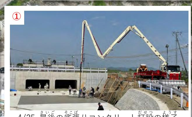
4/25 最後の底張りコンクリート打設の様子
