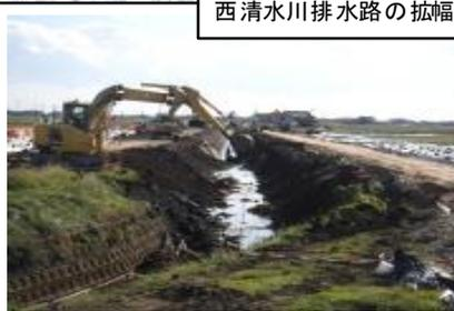
令和3年11月 積ブロック取壊し工 (西清水川排水路その3工事)
