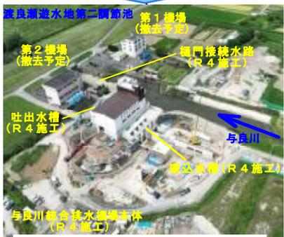
令和4年9月 (吸込水槽本体・呑口部、吐出水槽本体・暗渠、接続橋、建築建屋本体、樋門接続水路施工)
