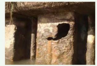
幹線排水路の鋼矢板腐食孔
