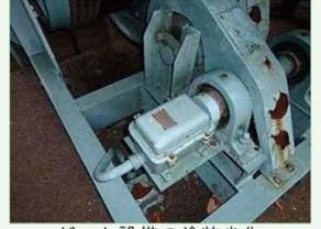
ゲート設備の塗装劣化
