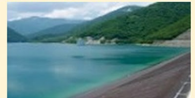
「深山ダム」那須野原地区
