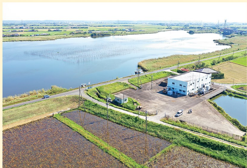
伊崎排水機場（新利根川沿岸地区）
