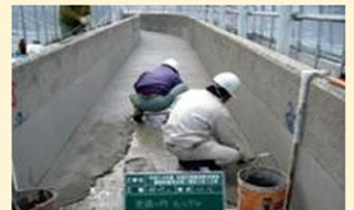
ポリマーセメントモルタルによる補修状況
