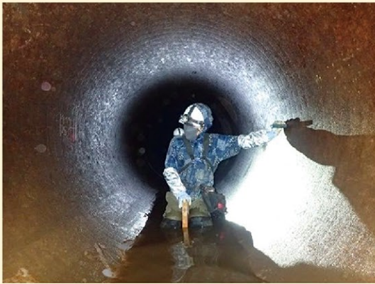
機能診断調査（パイプライン）
