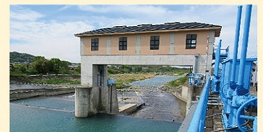
「神流川頭首工」神流川沿岸地区
