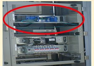
PLC構成局（NTT専用回線）
