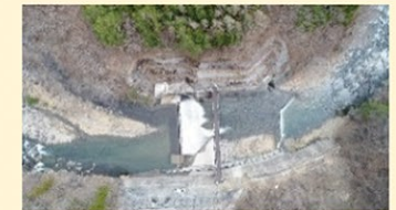
活用例②：農業水利施設の状況調査
