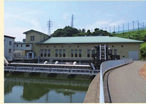
第1揚水機場（建屋）
