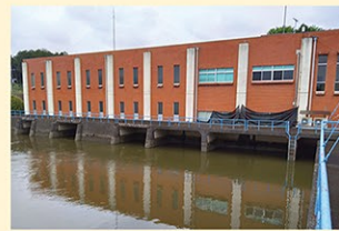
中央管理所（第2揚水機場）
