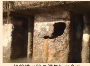
幹線排水路の鋼矢板腐食孔
