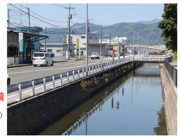
水路断面の改修により豪雨時の溢水を防止(令和3年4月)
