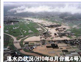
湛水の状況（H10年8月台風4号）
