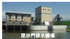
毘沙門排水機場
