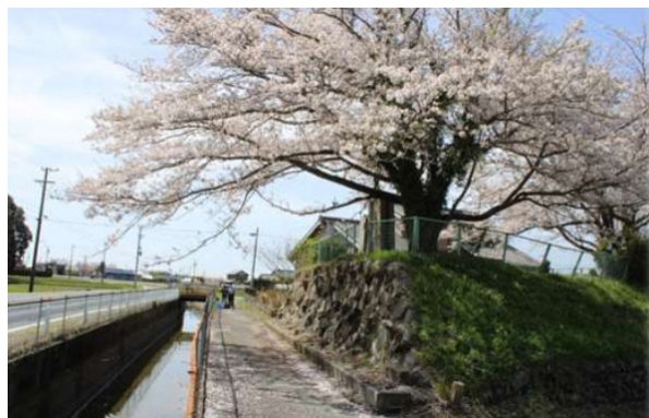
現在の水路（大塚樋跡）
