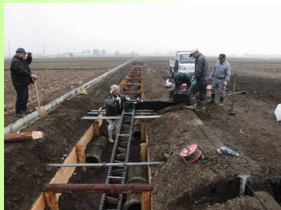
水田魚道の設置風景
