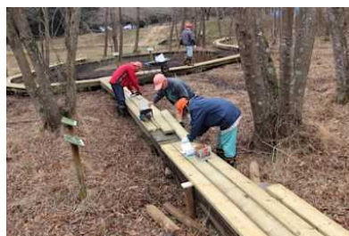
ビオトープ整備 「木道の補修作業」
